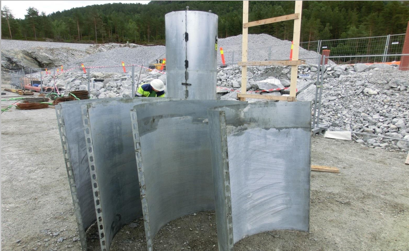
Trafostasjon på Moskog i Sogn og Fjordane. Viser teleskopforskaling. Diameter Ø800mm. 2 element. Høyde opp til 2300mm.
