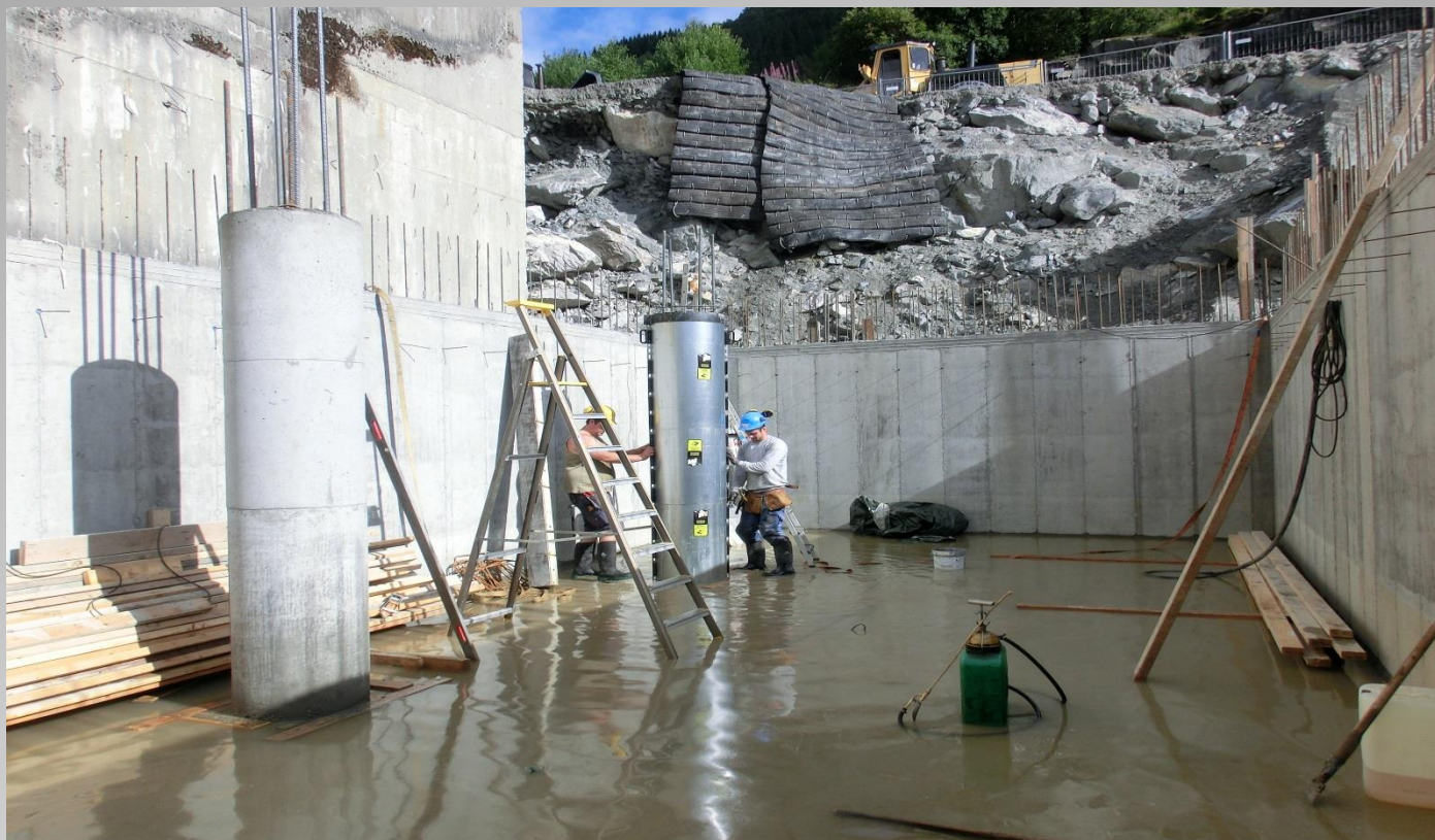
Nybygg til Sunnfjord Betong AS i Førde. Søyleforskaling for betongsøyler under tilslagssiloer. Diameter Ø500mm.
