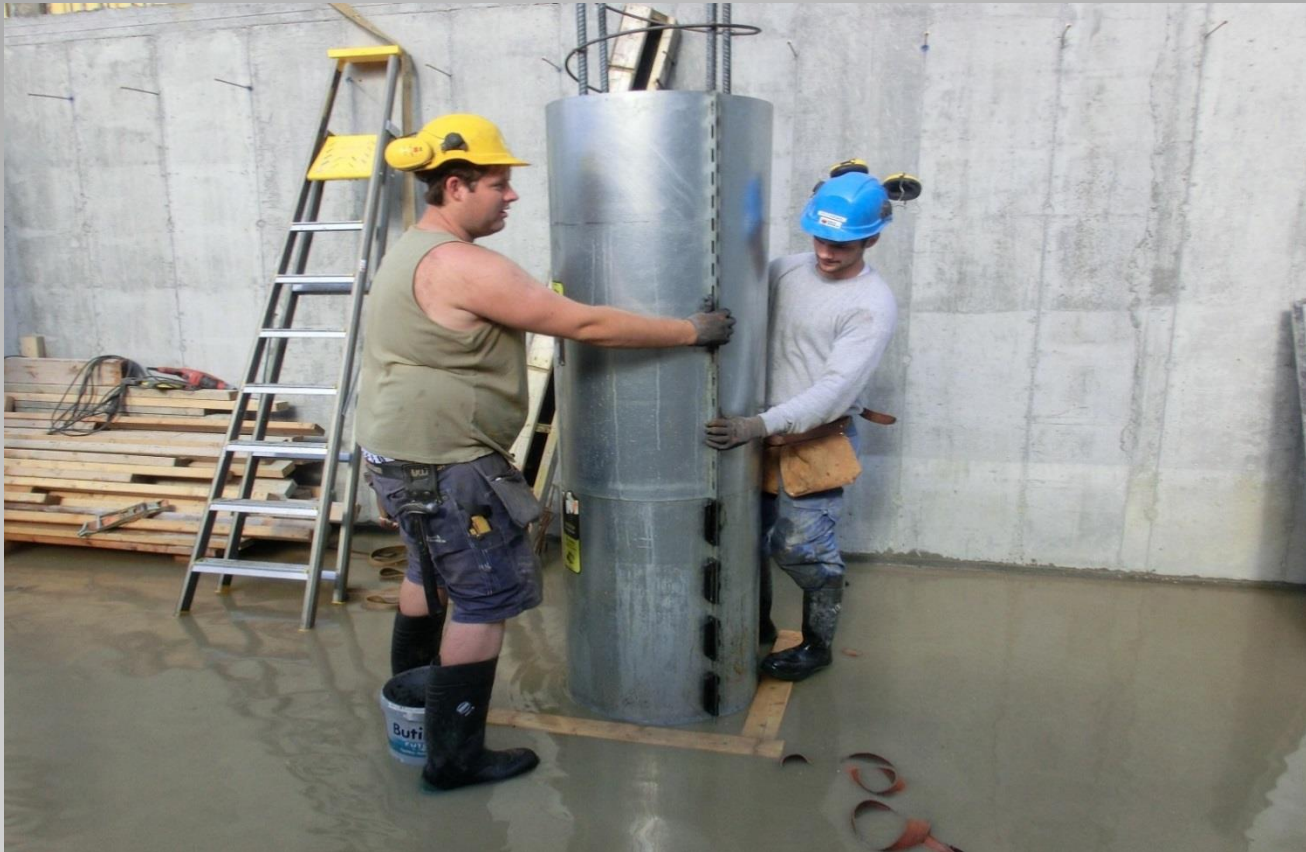
Nybygg til Sunnfjord Betong AS i Førde. Søyleforskaling for betongsøyler under tilslagssiloer. Diameter Ø500mm.
