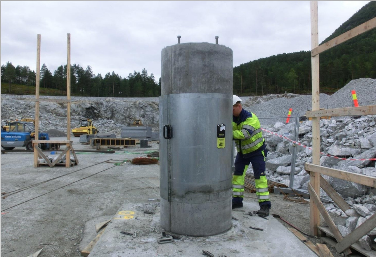
Trafostasjon på Moskog i Sogn og Fjordane. Fjerning av forskaling etter støp.
