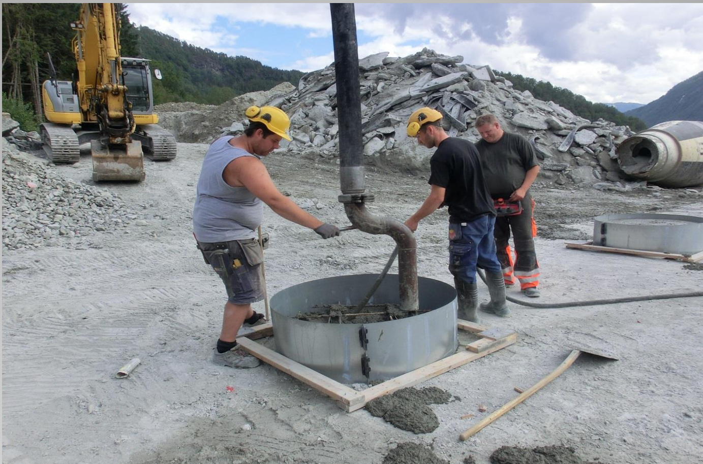
Nybygg til Sunnfjord Betong AS i Førde. Fundament-forskaling for byggekran.
