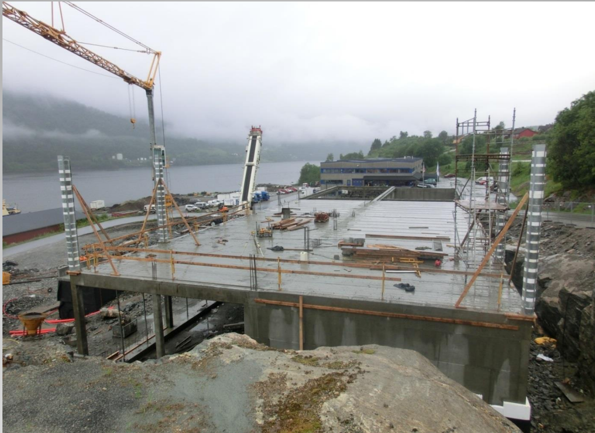
Hornnes Eiendom AS i Førde. Kvadratisk forskaling 300 x 300mm. Høyde 5000mm.
